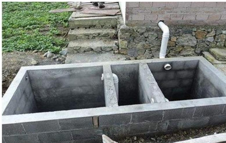
图 4-6 砖砌（或钢筋混凝土）三格化粪池示意图
